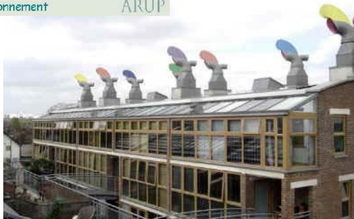
Les immeubles de logements BedZED, au Sud de Londres, sont des exemples où le traitement de la ventilation naturelle avec récupération de chaleur fait partie de la conception architecturale et l'esthétique de l'ensemble. Ce système de ventilation naturelle permet de récupérer une partie des calories émises
